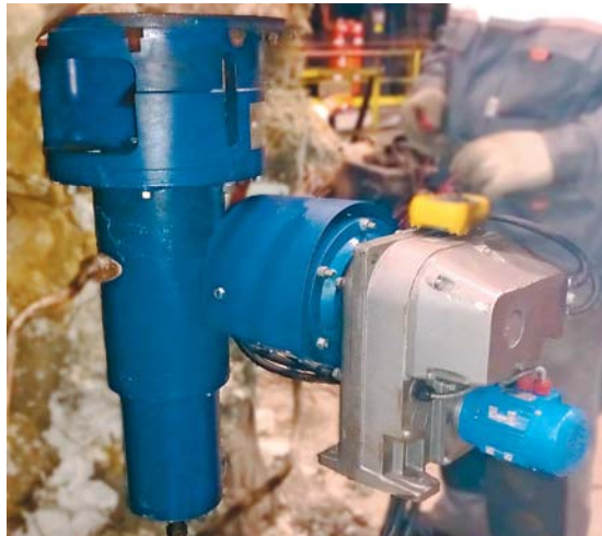
Рис. 1. ЭМП тип I стопорного клапана турбины К-19 (НЗЛ), ТЭЦ АО «Евраз НТМК»
