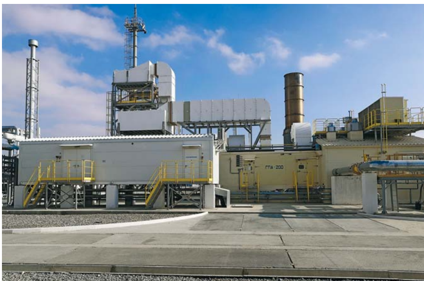
Рис. 3. ГПА блочного исполнения. ДКС «Самантепе», Узбекистан
