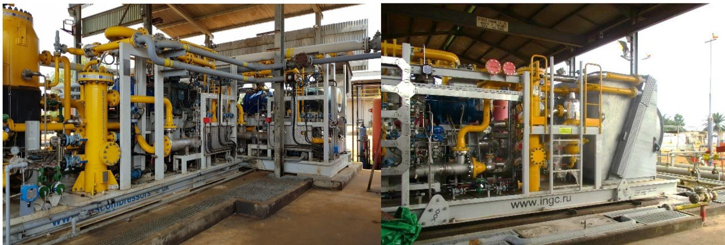
5.2. , специалистами ИНГК продолжают шеф-монтажные работы на 12-ти агрегатах ПКУ008 (Поршневые компрессорные установки мощностью 3700кВт с приводом «Caterpillar» G3616 LE и компрессором КВУ/6 производства «Ariel» для нужд АО «Востсибнефтегаз».
