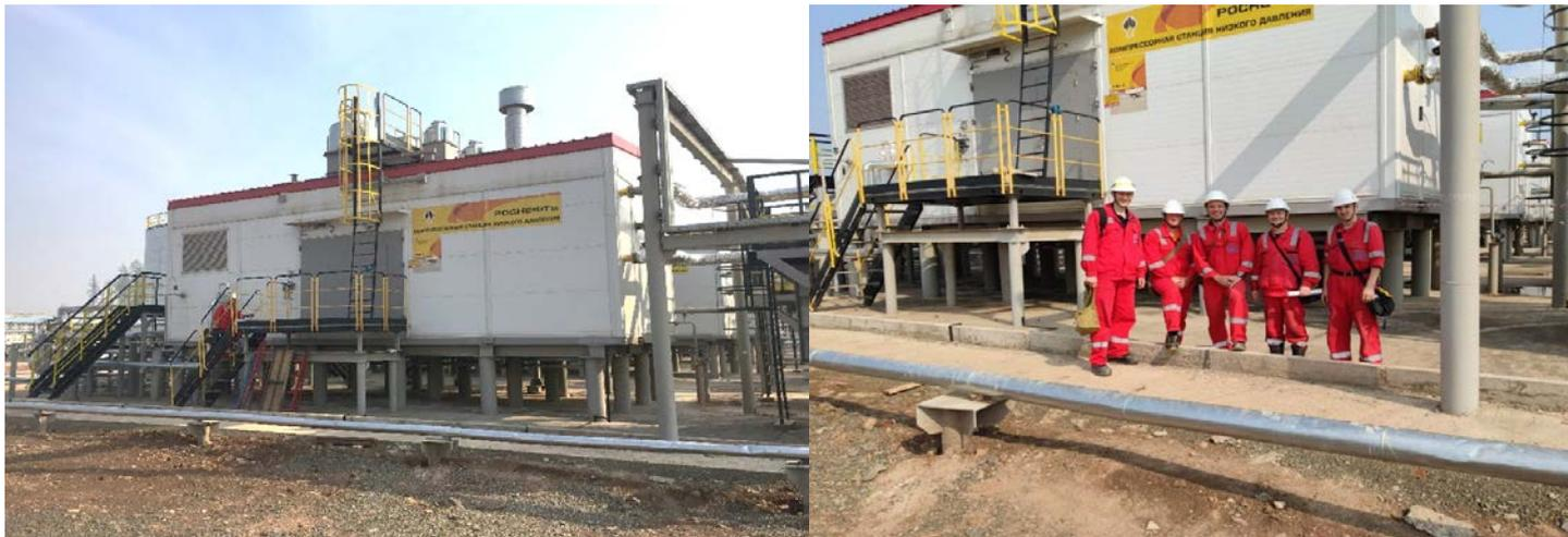
5.4. Завершились пуско-наладочные работы ВКУ002 в рамках строительства компрессорной станции на ДНС-2 для утилизации газа с 1-й и 2-й ступени сепарации (г. Когалым, Повховское месторождение). Установка ВКУ002 прошла требуемые испытания и запущена в эксплуатацию. Нареканий в работе со стороны заказчика не выявлено.
