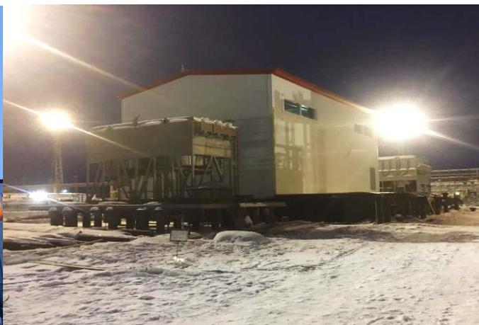
5.8. Осуществляются доработки 3-х КМЧ для ЭГПА на Еты-Пуровском месторождении (для ООО «Газпром добыча Ноябрьск», заказчик АО «РЭПХ»), выполнены замечания по системам после монтажа. Идет подготовка к холодной прокрутке.
