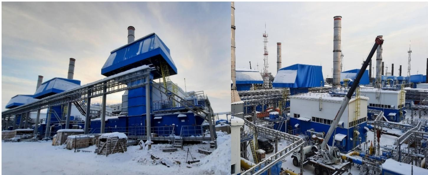
5.7. Продолжается комплекс монтажных работ на ПКУ016 мощностью 2,64 МВт (двигатель производства «Caterpillar» G3612, с поршневым компрессором «Ariel» KBZ/4) на Пырейном НГКМ (для ООО «Сибнефтегаз»), начатый в сентябре 2020 года. Осуществляются работы по сборке ангарного укрытия.
