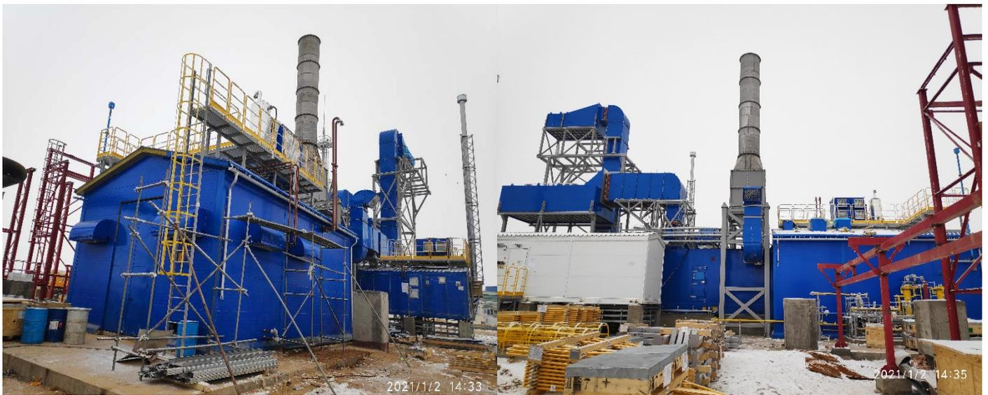
На данный момент ГПА серии «Иртыш» для ДКС «Алан» находятся на этапе монтажных работ. Произведен монтаж основных систем, ведется завершающий этап сборки и в ближайшее время состоится подача электропитания на оба ГПА.
