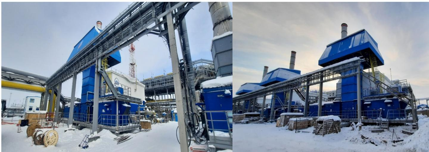
13. Завершаются работы по выполнению комплекса монтажных работ на **ПКУ 016** мощностью **2,64 МВт** (двигатель производства «Caterpillar» G3612, с поршневым компрессором «Ariel» KBZ/4) на Пырейном НГКМ (для ООО «Сибнефтегаз»), начатые специалистами компании в сентябре 2020 года.
