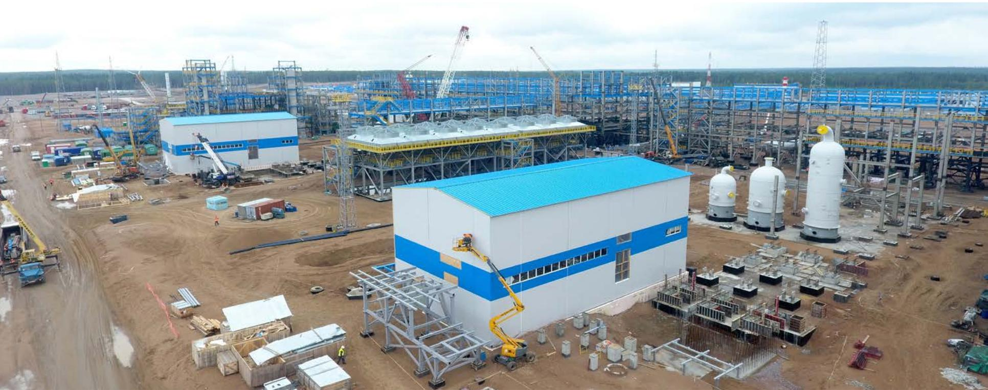
Монтаж силовых каркасов, стеновых и кровельных сэндвич панелей, ворот, доборных элементов, оконных блоков, систем пожаробнаружения, пожаротушения, вентиляции и т.п
