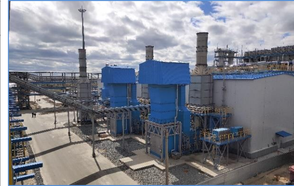
ГПА--6МВт и ГПА-10МВт в ООО «Газпром переработка»
