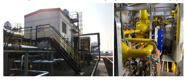
21. Все **12-ть** агрегатов **ПКУ 008** на Юрубчено-Тохомском месторождении (АО «Востсибнефтегаз») мощностью **3700 кВт** (с поршневым компрессором KBU/6 Ariel»и приводом от газопоршневого двигателя G3616 LE Caterpillar) полностью смонтированы на объекте (**10** агрегатов уже сданы в эксплуатацию, **2** - в завершающей стадии работ).
