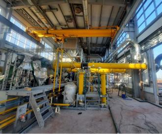
Специалистами компании осуществляются работы по монтажу системы вентиляции, монтажу металлоконструкций под электропроводку межблочную, осуществляется выставка патрубков компрессора в проектное положение, идет проверка планово-высотного положения рамы блока привода и рамы блока приводного оборудования.
