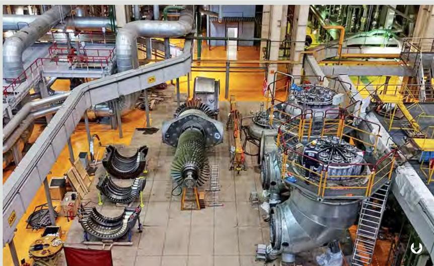
**Выполнена главная инспекция газотурбинной установки на ТЭЦ-27 Мосэнерго.**
