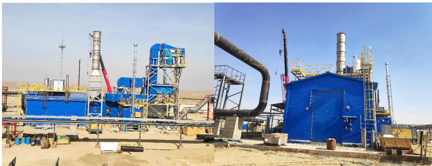
Объект ДКС «Зеварды» также на этапе монтажных работ. Производится монтаж основных систем: система масло обеспечения, система выхлопа.
