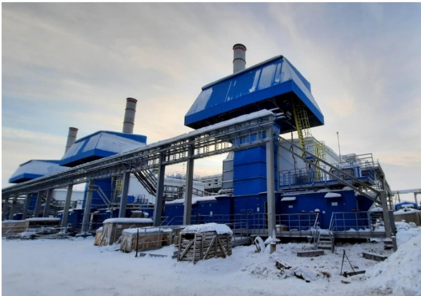
12. Продолжаются работы по выполнению комплекса монтажных работ на ПКУ016 мощностью 2,64 МВт (двигатель производства «Caterpillar» G3612, с поршневым компрессором «Ariel» KBZ/4) на Пырейном НГКМ (для ООО «Сибнефтегаз»), начатые специалистами компании в сентябре 2020 года. В начале 2021 году выполнены работы по сборке ангарного укрытия, установок АВО и площадок обслуживания.
