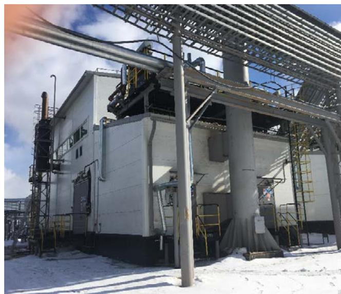
Всего изготовлено и поставлено на объект **12-ть** комплектов ПКУ 008 мощностью **3700 кВт** (с приводом от газопоршневого двигателя G3616 LE производства «Caterpillar» и поршневым компрессором KBU/6 производства «Ariel»).
