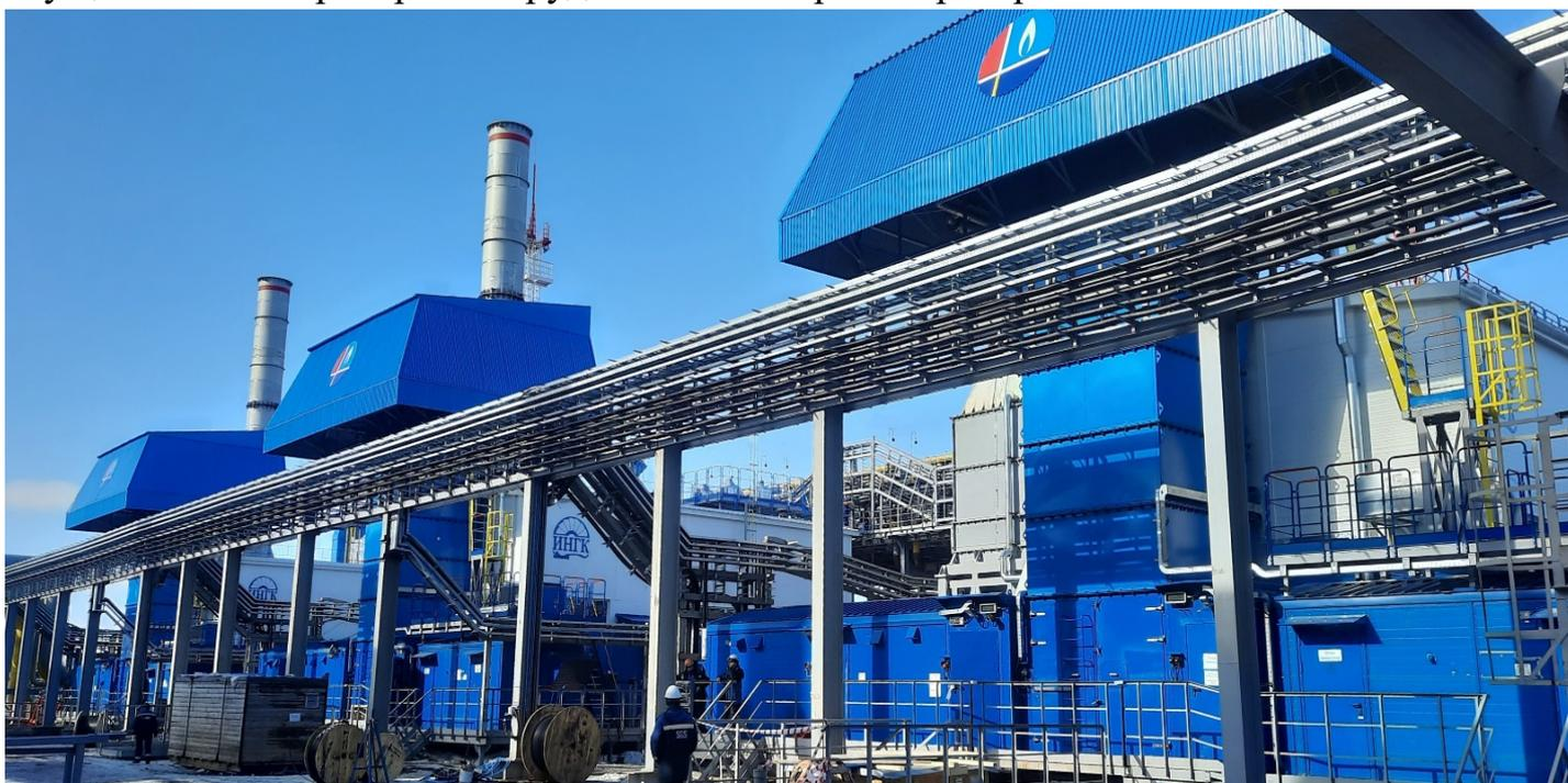
13. Продолжаются работы по выполнению комплекса монтажных работ на **ПКУ 016** мощностью **2,64 МВт** (двигатель производства «Caterpillar» G3612, с поршневым компрессором «Ariel» KBZ/4) на Пырейном НГКМ (для ООО «Сибнефтегаз»), начатые специалистами компании в сентябре 2020 года.
