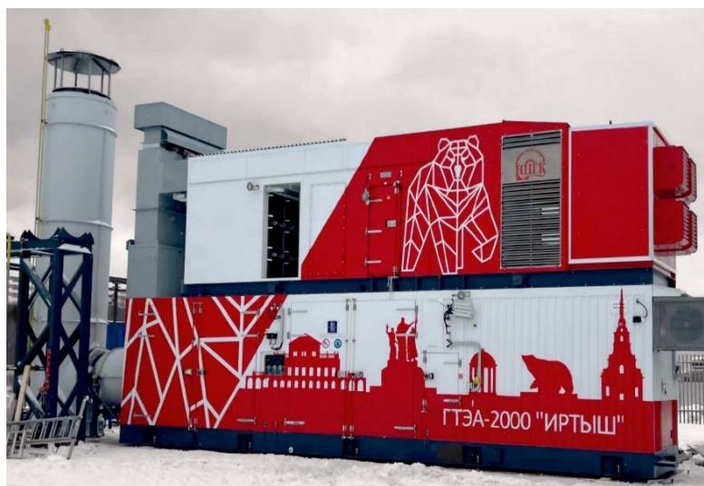
Агрегат обладает целым рядом преимуществ: многотопливность (природный газ, попутный газ, нефть – без необходимости дополнительной подготовки и очистки); удлиненный межремонтный период (за счет простоты и уникальности конструкции); блочно-модульное исполнение (в блоках высокой степени заводской готовности); мобильность (транспортировка тремя обычными трейлерами и монтаж на проектной площадке за 48 часов); отсутствие необходимости устройства фундамента (лишь
