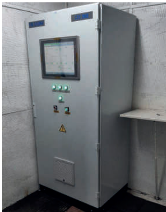
Рис. 6. Система автоматического управления электромагнитным подвесом (САУ ЭМП)
