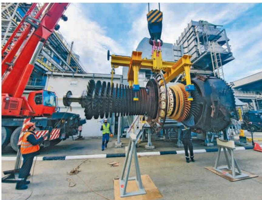
Рис. Демонтаж газовой турбины для выполнения ремонта в условиях предприятия
