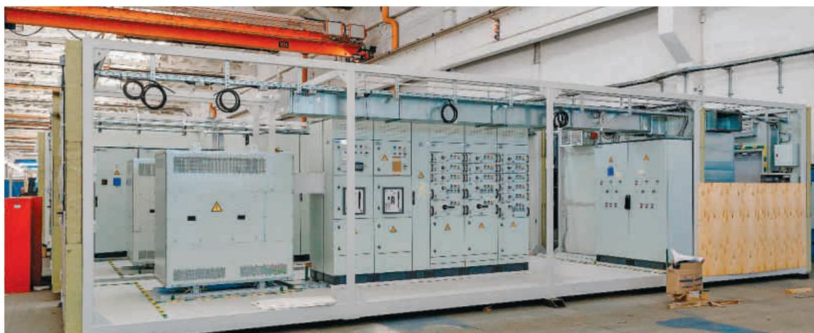
Рис. 4. Модуль питания и управления насосной станции дизельного топлива
