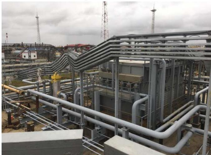
18. Продолжаются работы по монтажу **Поршневых компрессорных установок на Отрадненском ГПЗ** для нужд **ПАО «Роснефть»**. Блочные КУ К107 для подачи ПНГ, К117 – для компримирования сухого газа.
