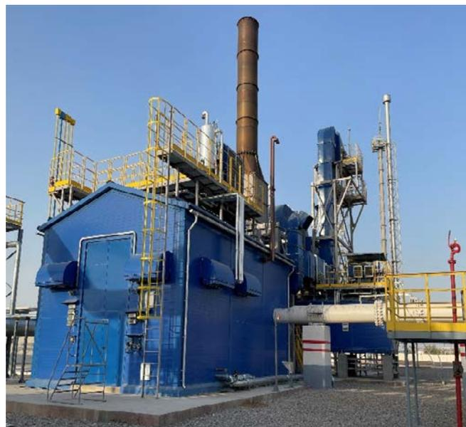
16. Продолжаются монтажные работы на **Компрессорной станции** для транспорта и закачки в пласт попутного нефтяного газа (ПНГ) на Ичёдинском НМ (для ООО «Иркутской нефтяной компании» («ИНК»)) для ГПА-16 МВт с ГТУ **Titan-130** и компрессором С61, производства Solar Turbines.
