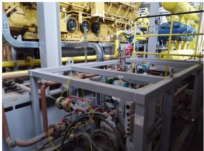
**ПКУ 010** оснащена электрическим приводом «Siemens» DHNL-910MC-06A и компрессором Ariel KBZ/4, **ПКУ009** с аналогичным компрессором и приводом от газопоршневого двигателя Caterpillar G3612.
