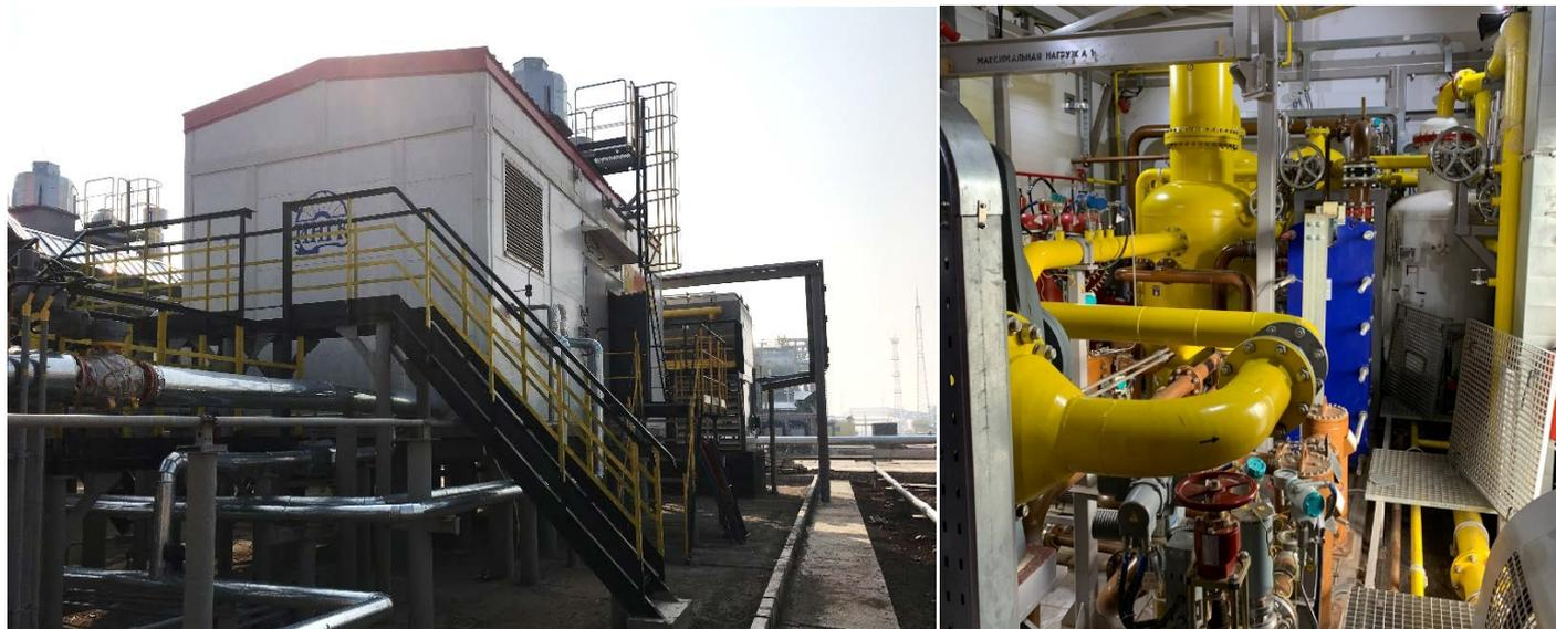
21. Все **12-ть** агрегатов **ПКУ 008** на **Юрубчено-Тохомском месторождении** (АО «Востсибнефтегаз») мощностью **3700 кВт** (с поршневым компрессором KBU/6 Ariel и приводом от газопоршневого двигателя G3616 LE Caterpillar) полностью смонтированы на объекте (**10** агрегатов уже сданы в эксплуатацию, **2** - в завершающей стадии работ).
