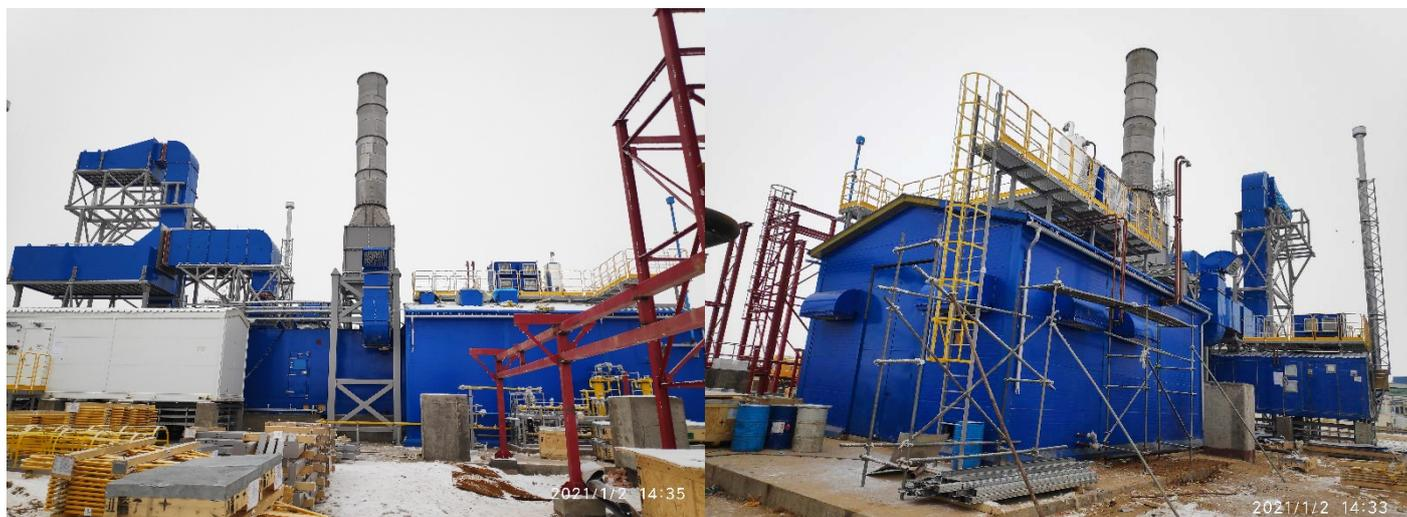
На данный момент объект ДКС «Алан» находится на этапе монтажных работ. Произведен монтаж основных систем, сборка ГПА и подача электропитания.
