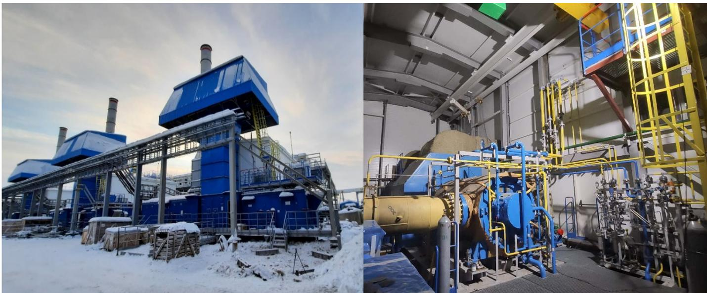
12. Комплекс монтажных работ на ПКУ016 мощностью 2,64 МВт (двигатель производства «Caterpillar» G3612, с поршневым компрессором «Ariel» KBZ/4) на Пырейном НГКМ (для ООО «Сибнефтегаз») начат в сентябре 2020 года.
