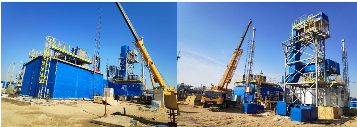
Объект ДКС «Зеварды» также на этапе монтажных работ. Произведен монтаж металлоконструкций из состава укрытия блока компрессора, производится установка и монтаж компрессора, блока привода, блока обеспечения.
