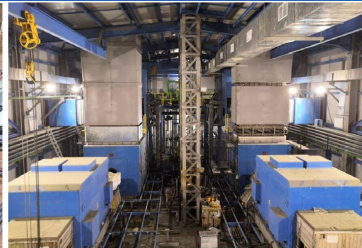
ГТЭА-12МВт в ООО «Газпром добыча Надым» (в стадии монтажа)
