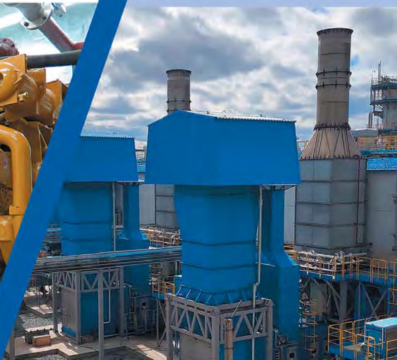
ГПА-6 МВт и ГПА-10 МВт «Иртыш», 1 шт. и 2 шт. ДКС Уренгойского ЗПКТ, ООО «Газпром переработка»
