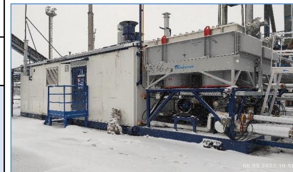
МКУ-001 на площадке ГПН-ННГ проходит ОПИ
