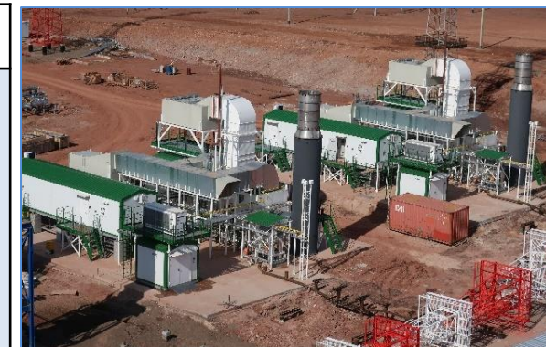
ГТЭА-6МВт в ООО «Иркутская нефтяная компания»
