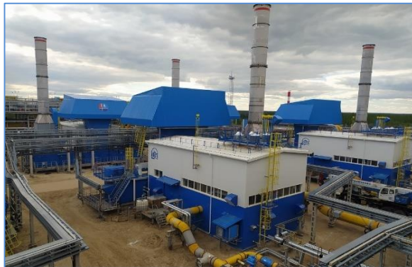
ГПА-16МВт в ООО «Севернефтегазпром»
