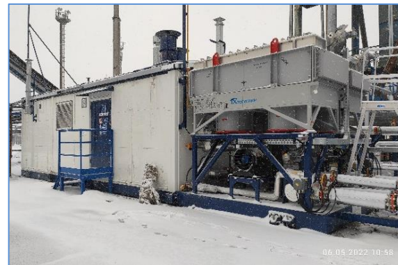
МКУ-001 на площадке ГПН-ННГ проходит ОПИ
