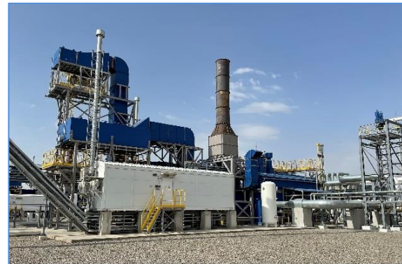
ГПА-8МВт и ГПА-16МВт в АО «Узбекнефтегаз»
