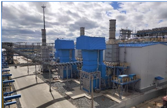
ГПА-6МВт и ГПА-10МВт в ООО «Газпром переработка»
