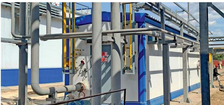
на каждой ГПС установлен модуль подогрева, состоящий из теплообменных аппаратов и узла сбора и хранения газового конденсата с дренажным резервуаром.
