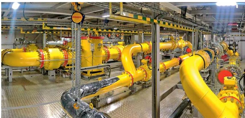
топлива на входе в блок отключающей арматуры турбин SGT-800. Концевая система фильтрации ЭНЕРГАЗ состоит из четырех фильтров вертикального картриджного типа пропускной способностью по 14 890 м<sup>3</sup>/ч.
