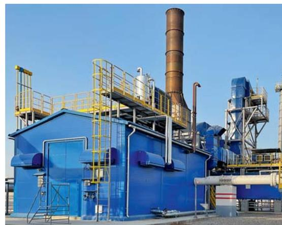
Мобильные компрессорные установки для перекачки газа из трубы в трубу
