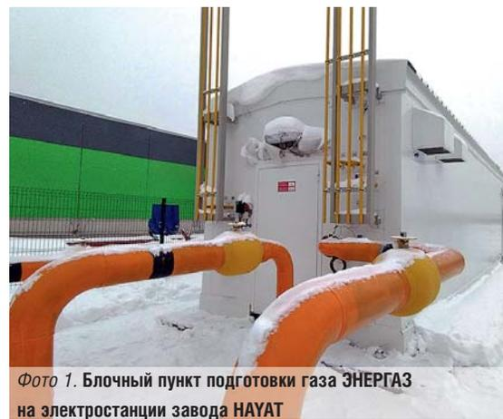
Фото 1. Блочный пункт подготовки газа ЭНЕРГАЗ на электростанции завода НАУАТ
