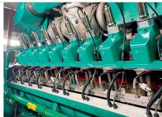
2. После данной модернизации эксплуатант получает полный контроль над агрегатом и может прогнозировать необходимость замены свечей и т.д., не дожидаясь аварийной остановки из-за пропуска зажигания или других процессов в цилиндрах агрегата.
