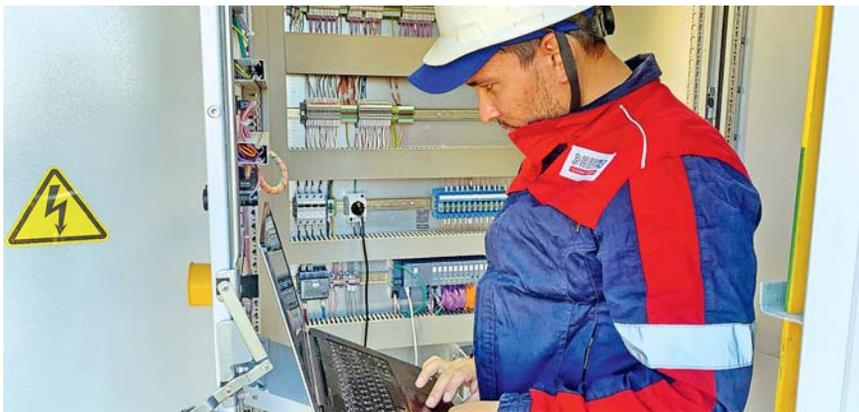
Фото 4. Настройка системы управления в ходе пусконаладочных работ
