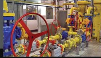
Блочные пункты подготовки газа
