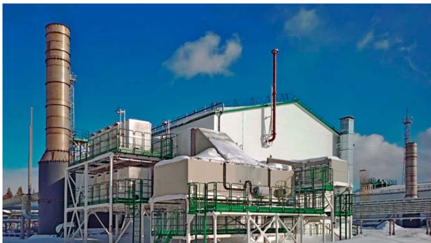
Фото 3. Блочный-модульный ГПА «Иртыш» на КС «Ярактинская» (Иркутская нефтяная компания)
