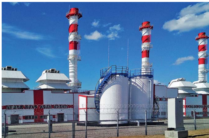
Газотурбинные энергоблоки размещаются попарно в легкосборных зданиях
