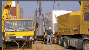
Доставка и монтаж
